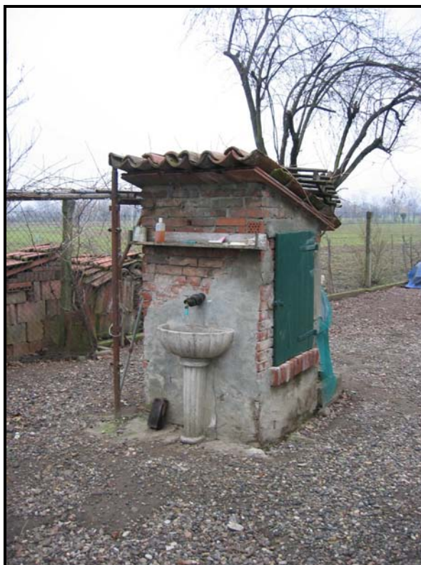
Foto n°2: Un tipico pozzo a camicia utilizzato per le misure freatiche ubicato in loc. Crocetta
